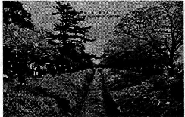
小金井橋から下流を見た景観（大正時代）
